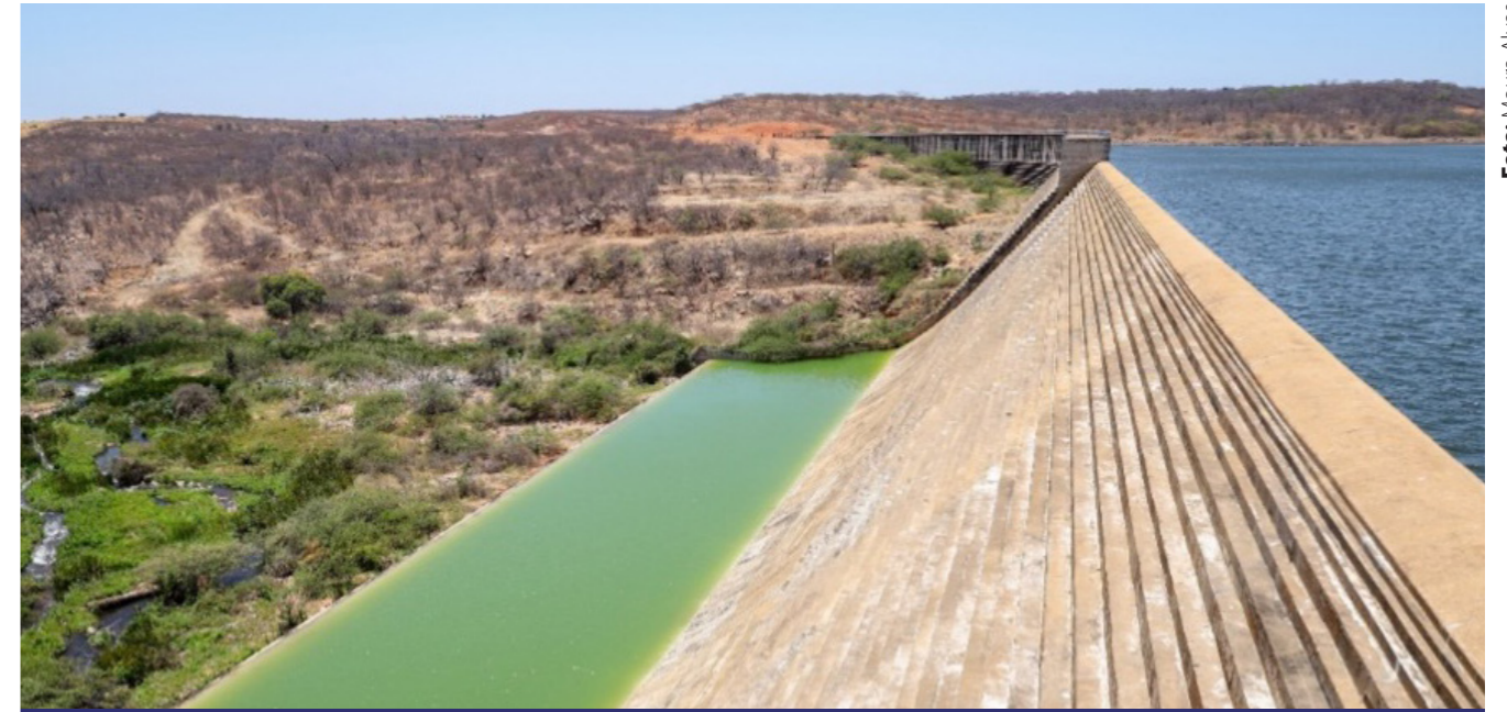
Barragem Poços de Marruá, em Patos do Piauí.
