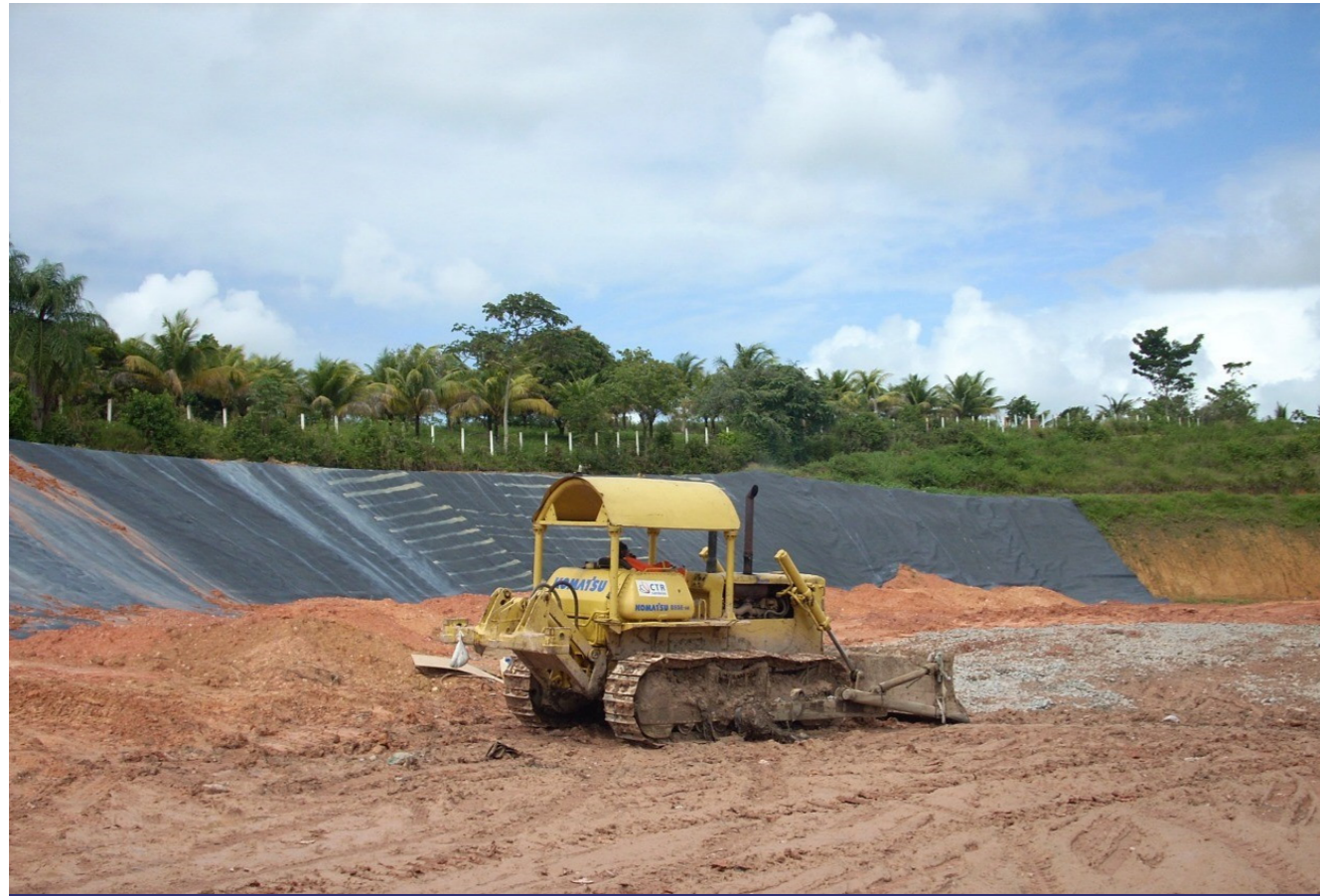
Aterro sanitário de Jaboatão dos Guararapes.
