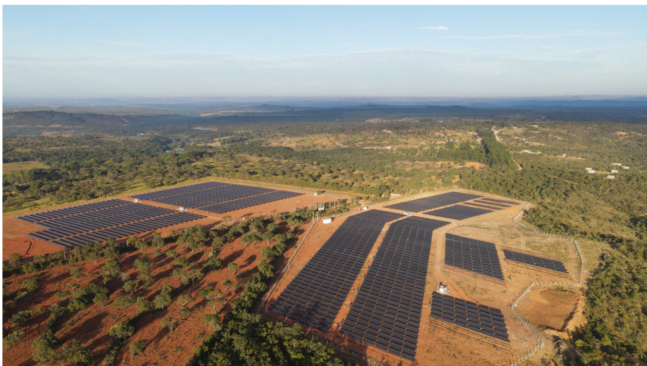
Entre as contribuições do Sol de Minas, está o fortalecimento da cadeia produtiva da geração de energia elétrica fotovoltaica.
