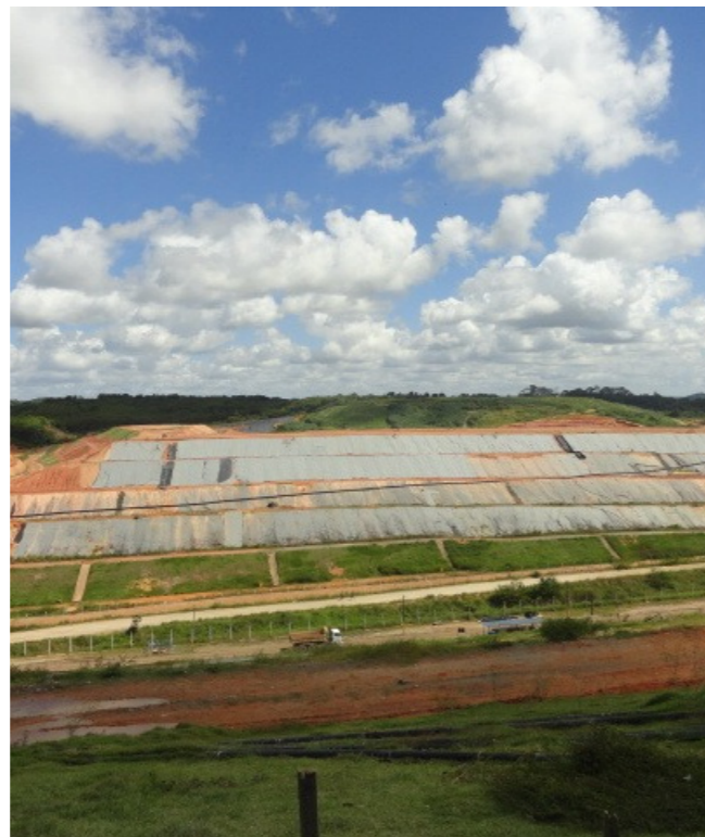
Aterro sanitário de Jaboatão dos Guararapes.
