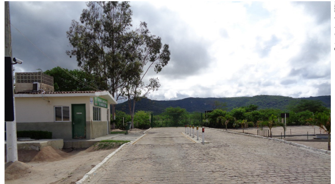
Aterro sanitário de Arcoverde.
